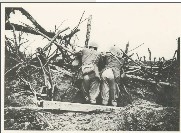
Poste de guetteur
