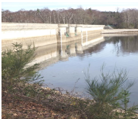
Barrage du Lac de Vassivière.
